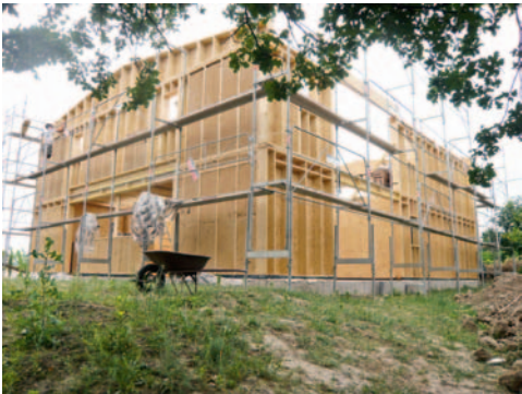
Assemblage La petite maquette de Kapla sert de point de départ au projet. Les containers sont acheminés jusqu'au chantier pour abriter le stockage et l'atelier. Ils sont ensuite recouverts par l'ossature en bois.
