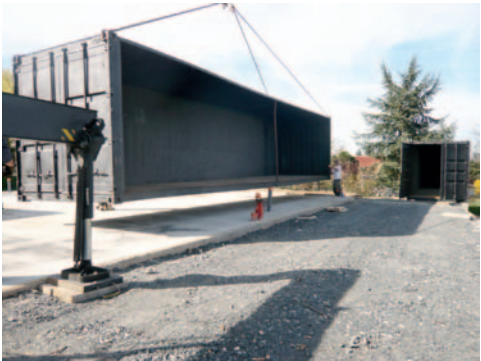
Assemblage La petite maquette de Kapla sert de point de départ au projet. Les containers sont acheminés jusqu'au chantier pour abriter le stockage et l'atelier. Ils sont ensuite recouverts par l'ossature en bois.
